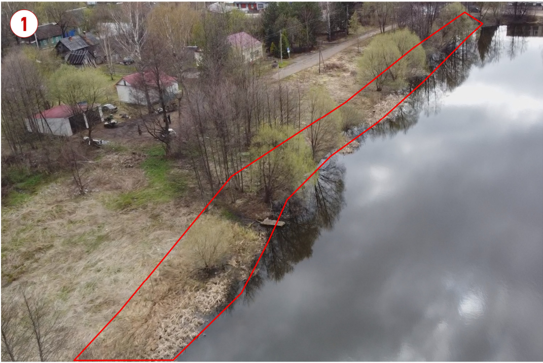
Отсутствие благоустроенных подходов к воде
