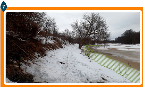
ОТСУТСТВУЮТ ПИРСЫ И ОБУСТРОЕННЫЕ НАБЕРЕЖНЫЕ, И ЗОНЫ ОТДЫХА У ВОДЫ
