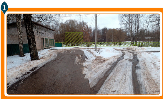
ОТСУТВИЕ ВХОДНОЙ ГРУППЫ
